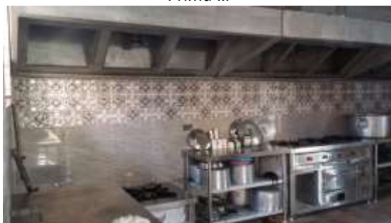
... e dopo l'intervento di ristrutturazione
